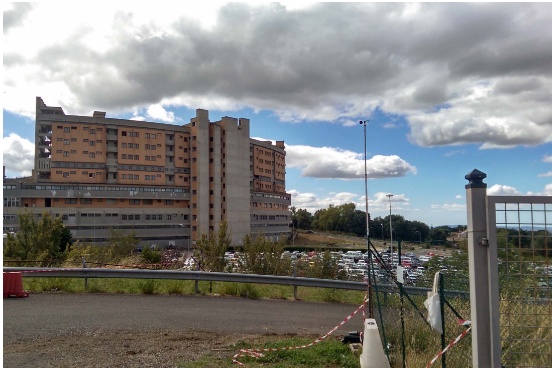
Figura 10: Immagine del punto di misura P4 (parcheeggio Nord)
