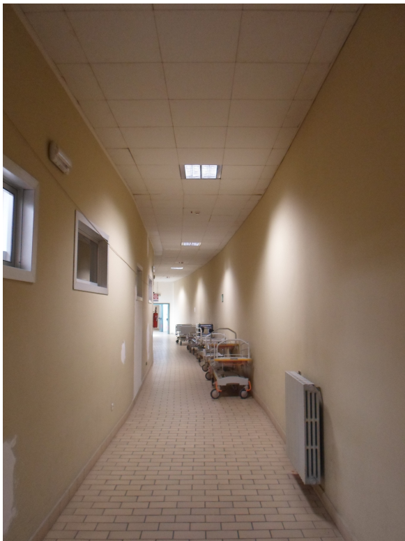
Foto 1 – corridoio di accesso al Laboratorio (escluso dall'intervento)
