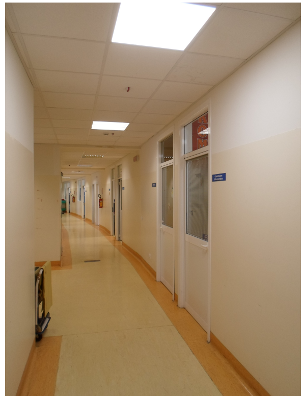
Foto 2 – corridoio interno al Laboratorio
