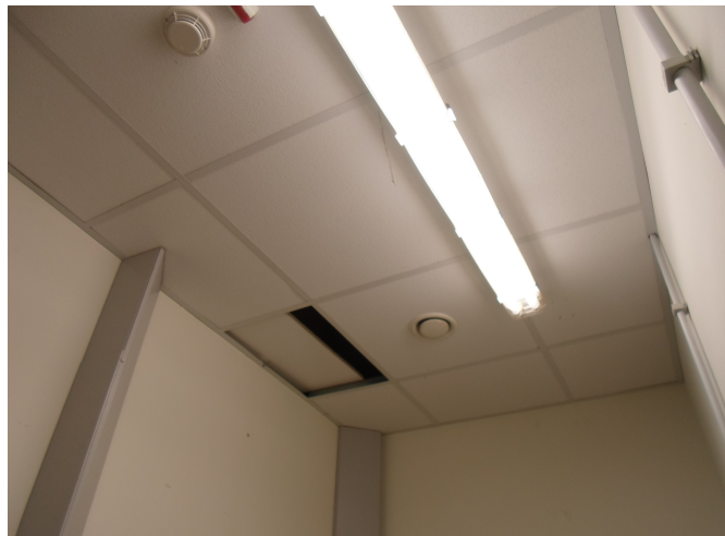
Foto 8 – controsoffitto ispezionabile in fibra minerale 60x60 cm
